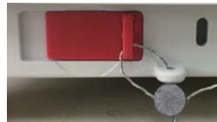
Bloccato con Sigillo di Cavo
